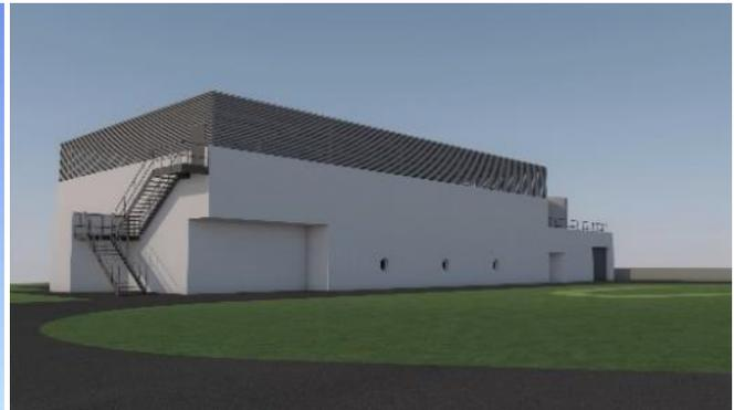
Der Neubau der EMV-Stufe wurde komplett nach der BIM-Methode geplant. Zur Koordination und Abstimmung wurden alle Fachmodelle zu einem Koordinationsmodell zusammengefügt. Es erfolgte eine virtuelle 3D-Begehung durch die Bauherrschaft mittels 3D-Brille vor der Umsetzung.
